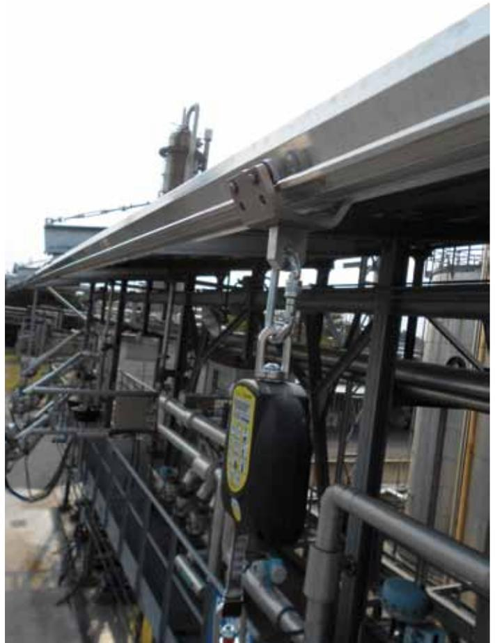
La linea a binario EN 795/D, essendo un sistema di ancoraggio rigido, in caso di caduta dalla sommità di un autotreno (anche con altezza limitata < di 3,5 m), impedisce all'operatore di cadere per terra, poiché la freccia del binario è nulla.
